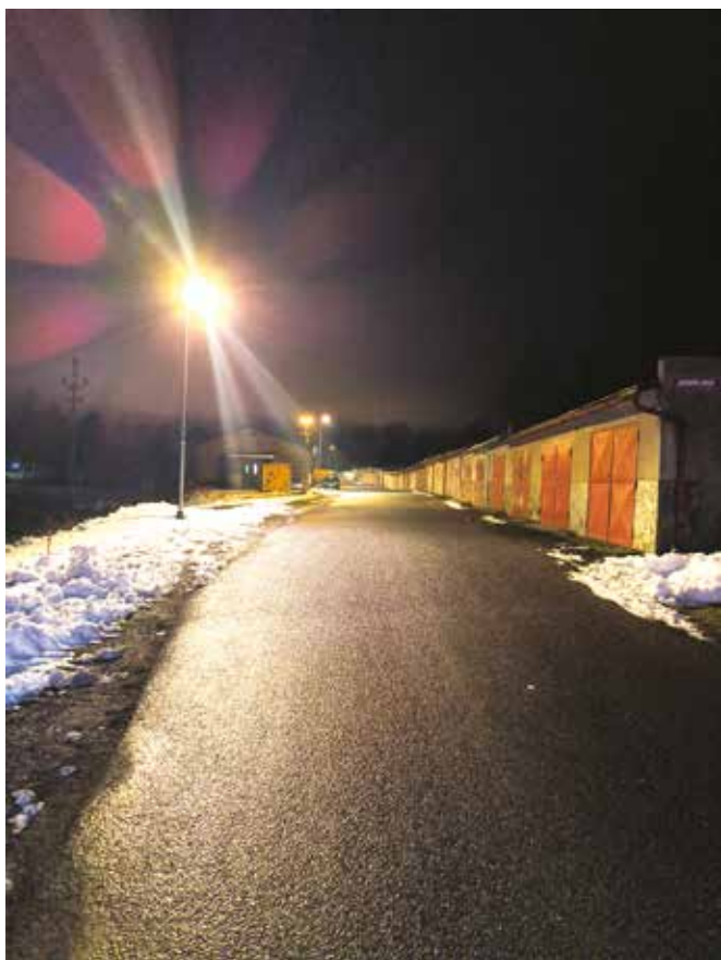
nové veřejné osvětlení J. Brože
