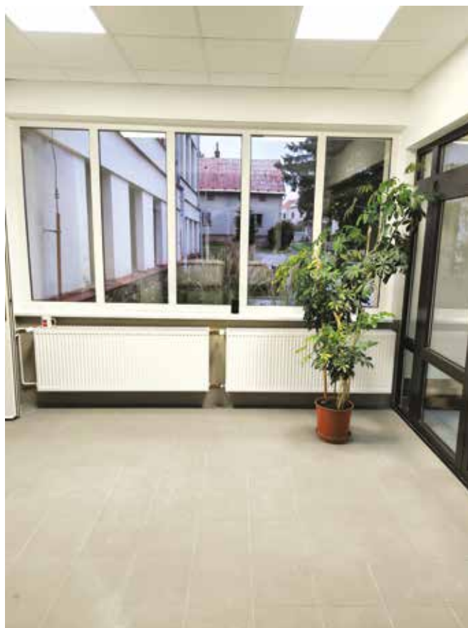
oprava vestibulu ZŠ
