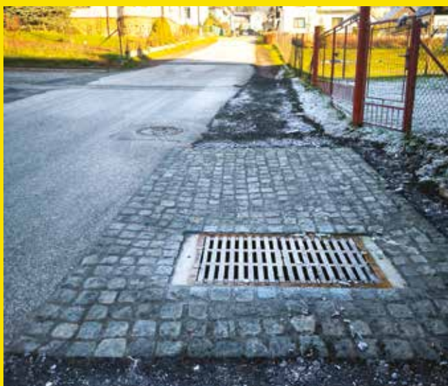
kanalizační vpust' ZŠ
