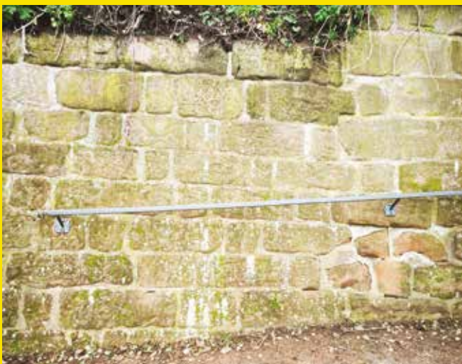
nové zábradlí Katolický hřbitov
