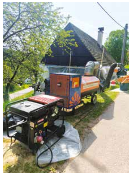
oprava Krsmol č.p. 9
