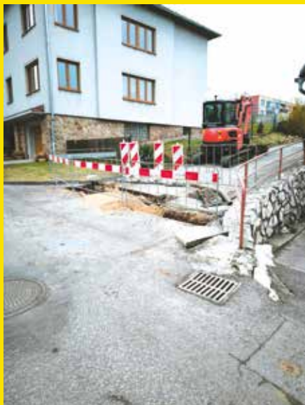
oprava kanalizace ulice Hartlova
