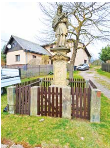
oprava plotu okolo sochy Brdo
