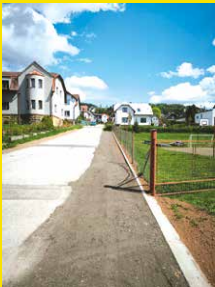
oprava komunikace u ZŠ
