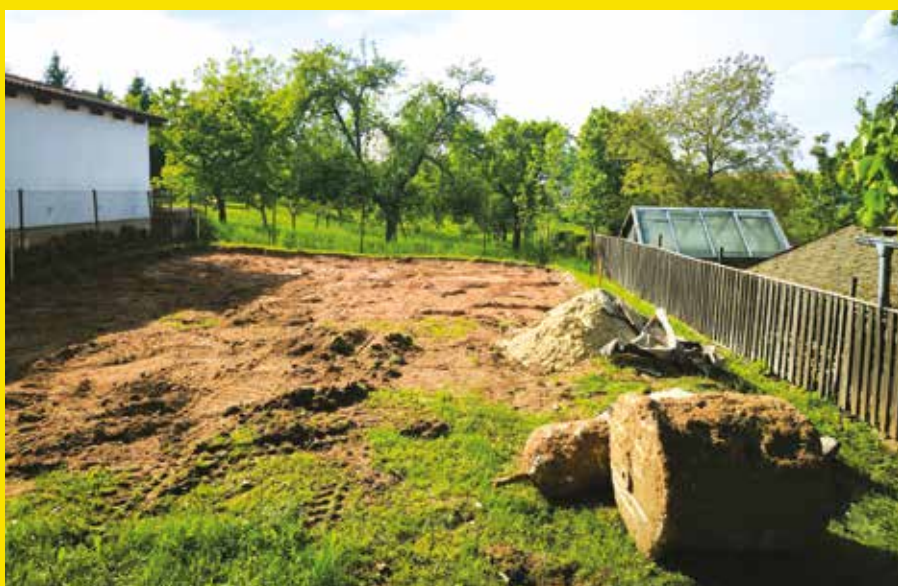
zahájení rekonstrukce hřiště Brdo
