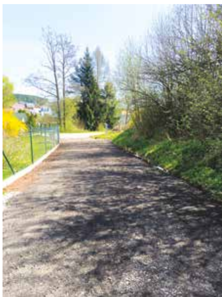
oprava komunikace A. Mlejnkové
