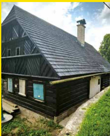
nátěry vnějších ploch Krsmol č.p. 9
