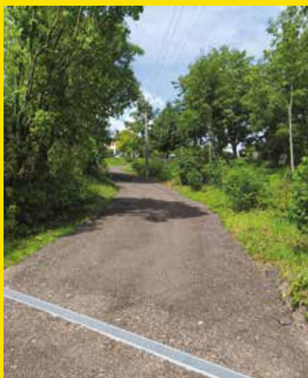
oprava cesty Brdo
