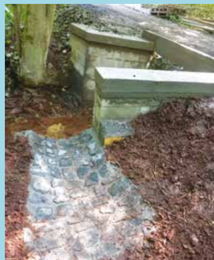
oprava propustku Karlov - vodárna
