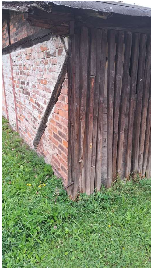
Obr. 5 Napadené sloupky a vodorovný podkladní trám dřevokaznými houbami a vlhkostí. Oba prvky jsou nedílnou součástí příčného ztužení objektu.
