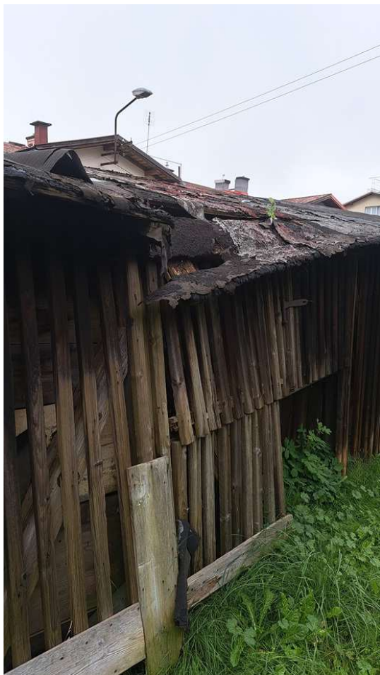
Obr. 7 a 8 – Totální degradace dřevěných nosných prvků způsobená dlouhodobým zatékáním do střešní konstrukce.
