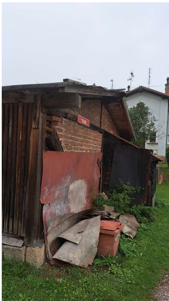
Obr.8 a 9 - Detail vykloněného zdiva a obvodový podkladní trám v pokročilém stádiu napadení dřevokaznými houbami.
