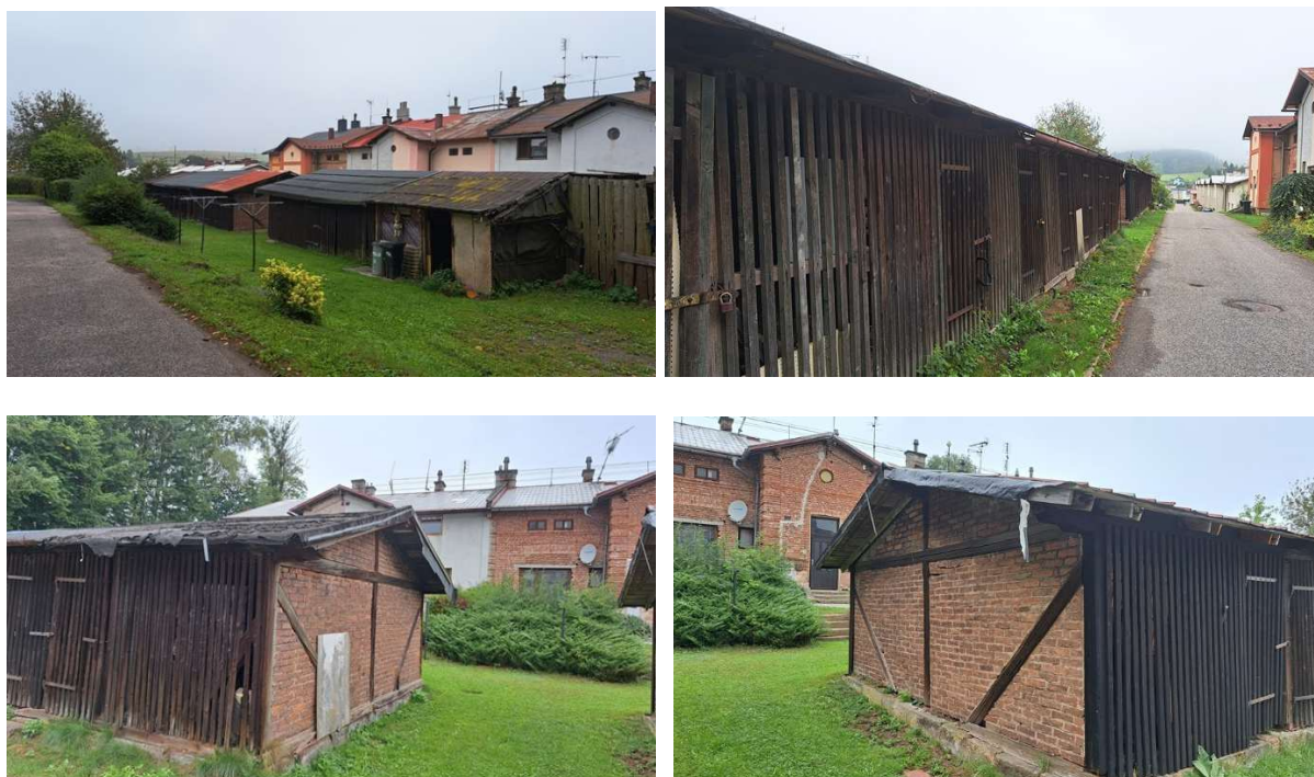
Obr. 3 – 6 Pohled na obvodové výplně
