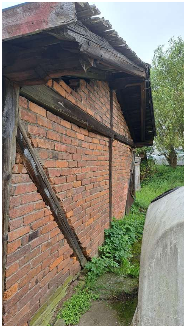
Obr. 6 a 7 – Rozpadlé štítové zdivo, základový trám již podlehl účinkům vlhkosti jímž byl dlouhodobě vystaven a s tím souvisí rozpad příčného ztužení ve štítu. Důsledkem je značná příčná deformace celého bloku.
