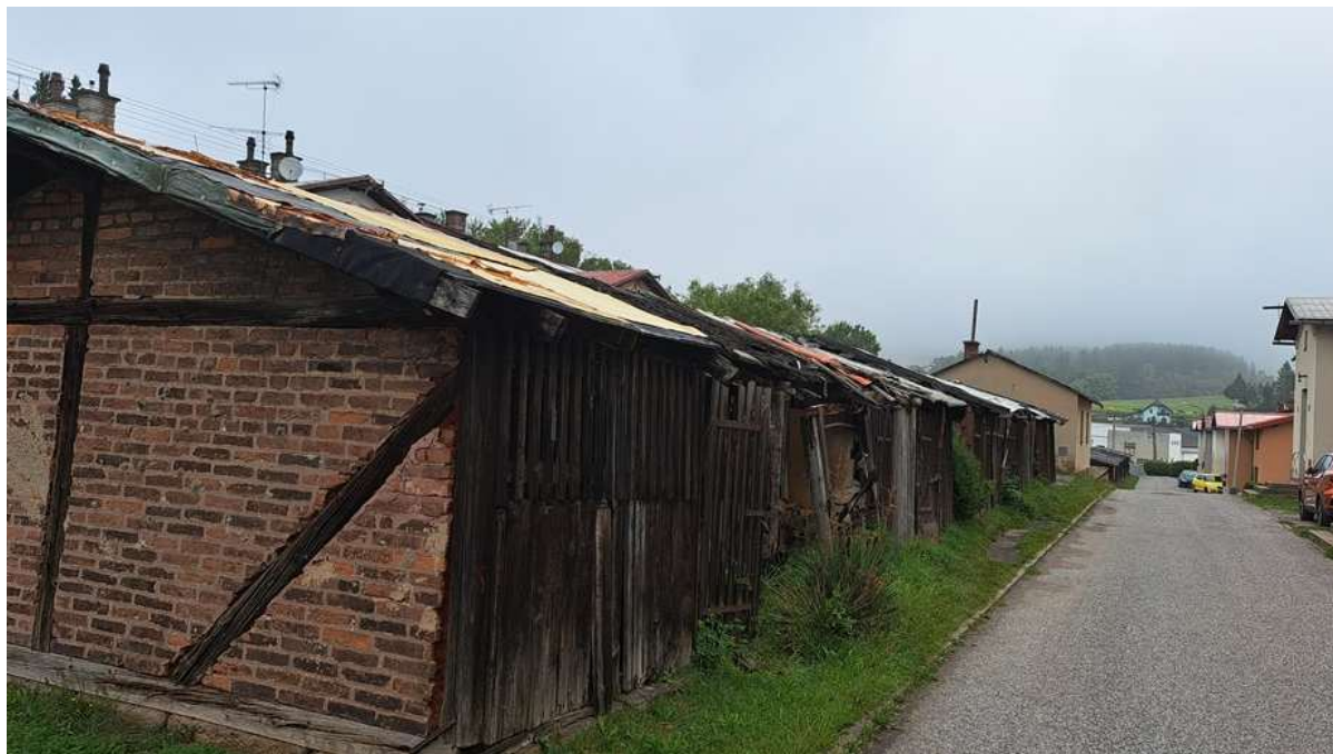
Obr.1 – Značná příčná deformace ve střední části objektu, konstrukční dřevěné prvky jsou zde napadené dřevokaznými houbami.
