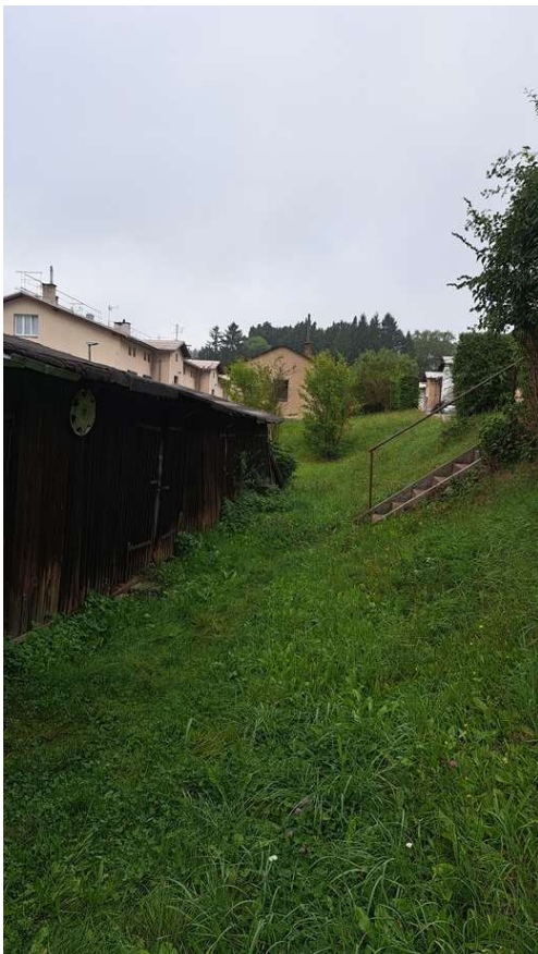
Obr. 1-4 – viditelná deformace nosné konstrukce objektu v příčném směru
