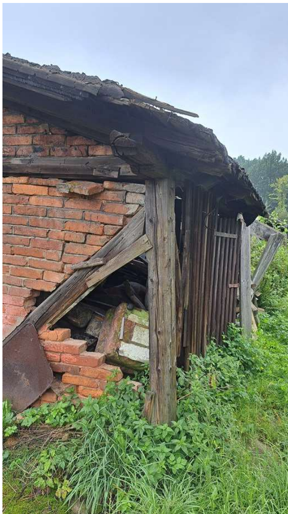
Obr. 6 a 7 – Rozpadlé štítové zdivo, základový trám již podlehl účinkům vlhkosti jímž byl dlouhodobě vystaven a s tím souvisí rozpad příčného ztužení ve štítu. Důsledkem je značná příčná deformace celého bloku.
