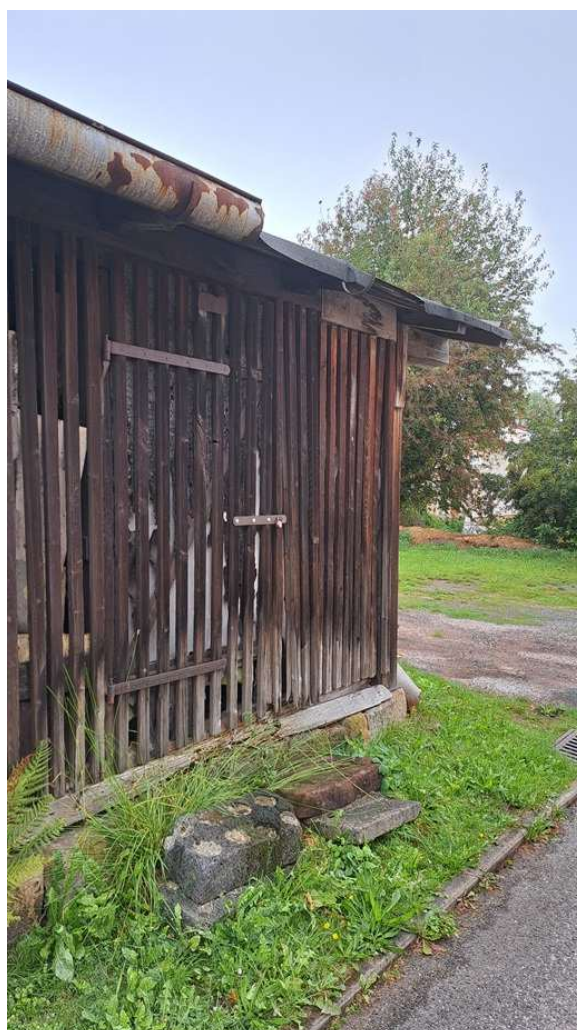
Obr.8 a 9 - Detail vykloněného zdiva a obvodový podkladní trám v pokročilém stádiu napadení dřevokaznými houbami.
