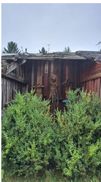
Obr.1 – Značná příčná deformace ve střední části objektu, konstrukční dřevěné prvky jsou zde napadené dřevokaznými houbami.
