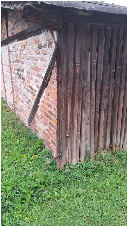
Obr. 5 Napadené sloupky a vodorovný podkladní trám dřevokaznými houbami a vlhkostí. Oba prvky jsou nedílnou součástí příčného ztužení objektu.
